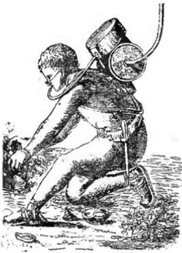
Fig. 79. — Scaphandrier revêtu de l'appareil Denayrouse.
