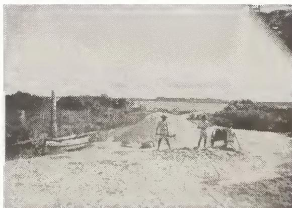
FIG. 81 — Transporte da “escoria” das salinas para fabricação de gesso. Note-se o canal que liga a Fábrica à Lagoa e o pequeno veleiro utilizado para o transporte da matéria-prima.
