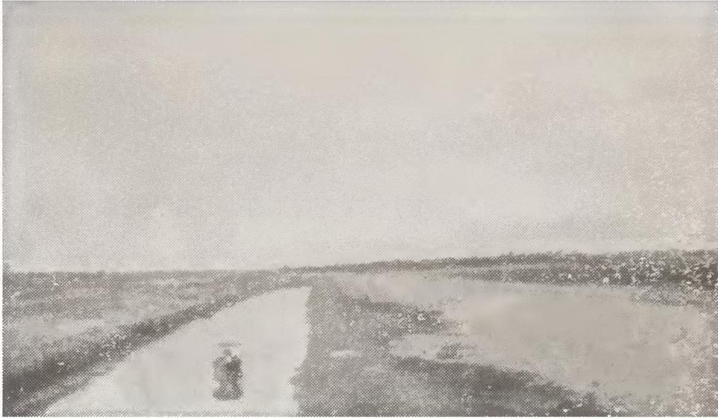
FIG. 49 — Canal do Pilar (Bacia do Iguaçu na Baixada da Guanabara); ao lado o dique construído à margem do leito maior. Vista tirada na época da estiagem.
