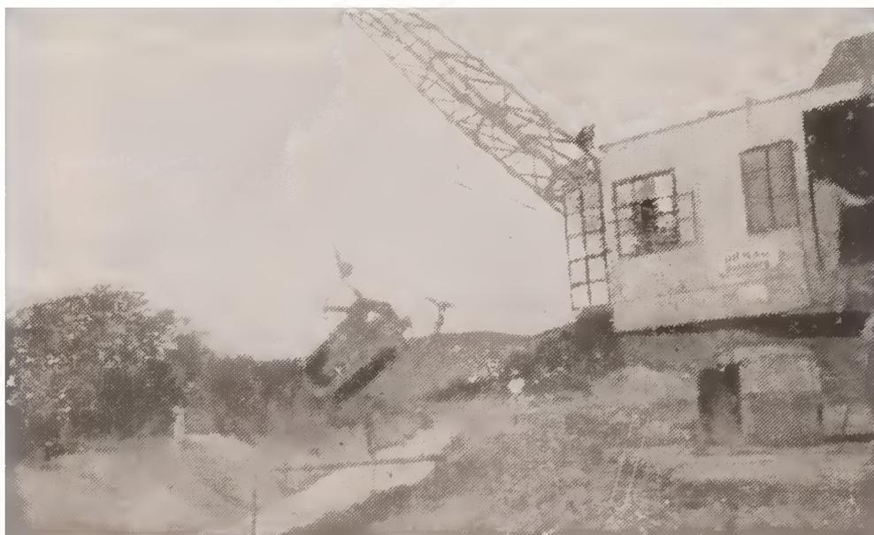
FIG. 47 — Dragagem do Rio Calombê na Bacia do Iguaçu, Baixada da Guanabara. A “dragline” repousa sôbre um estrado de dormentes devido à inconsistência do terreno.
