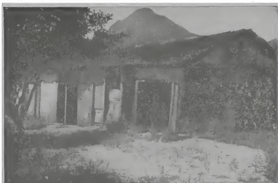
FOTO N.º 49 — Velha casa de estilo colonial, do século passado, posteriormente transformada em venda, hoje abandonada e em ruínas, na entrada sul do Canal de São Sebastião.
