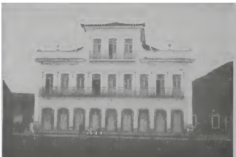
FOTOS N.os 31 e 32 — Sobrados do século passado, nas cidades de Ubatuba (foto 31) e de São Sebastião (foto 32). São poucos os casarões antigos conservados como estes, nos velhos centros coloniais da região, pois a maior parte ruiu ou está em ruínas.
