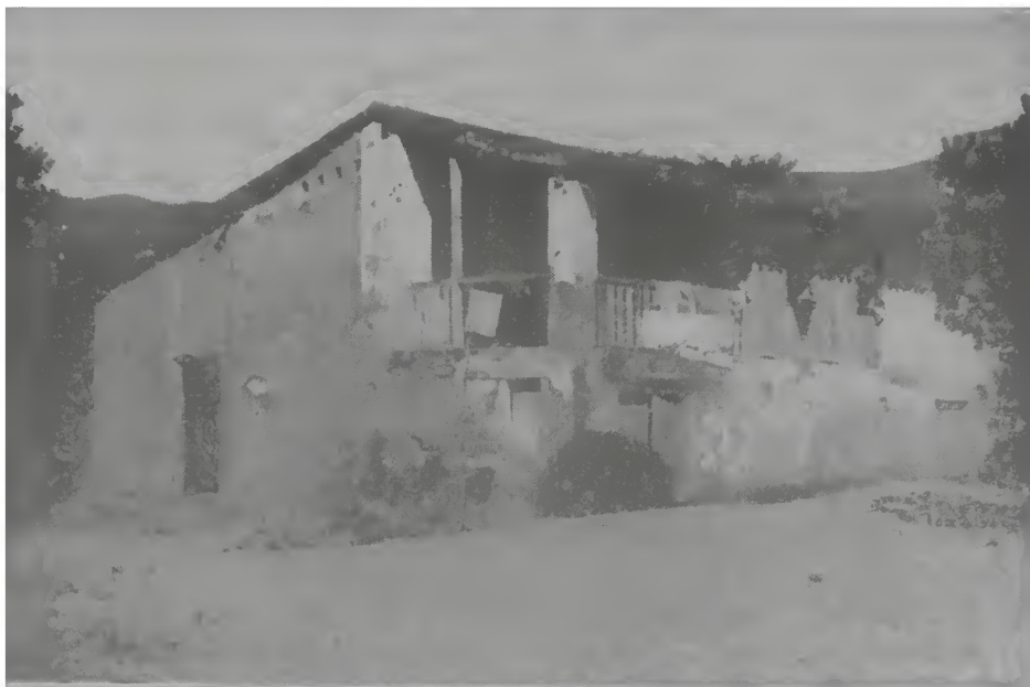
FOTO N.º 69 — Restos de um sobrado de engenho, cuja parte principal desabou. As ruínas são ainda habitadas.
