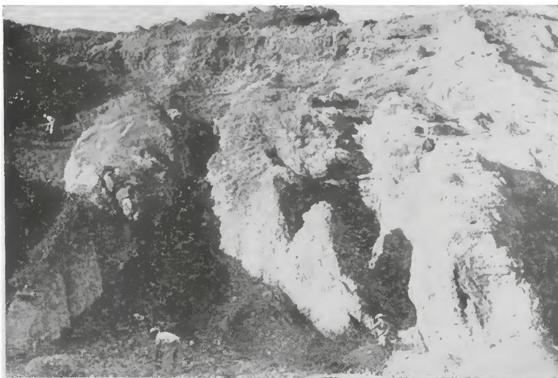
Fotografia 2 — Frente de desmonte de minério residual de apatita. Notam-se as juntas radiais subparalelas, alargadas por dissolução e preenchidas por minério de apatita.
