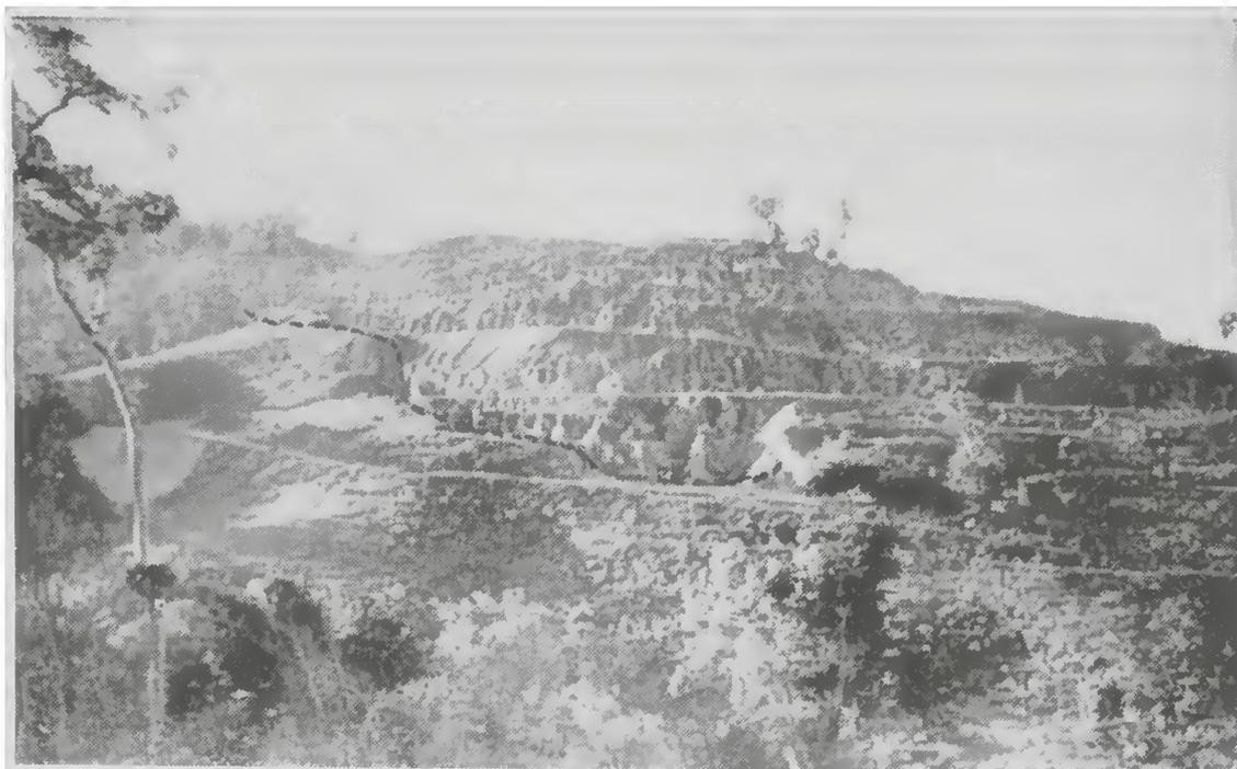
Fotografia 1 -- Vista da parte sudoeste do morro da Mina. Nas bancadas de lavra do minério observam-se as juntas radiais lixiviadas no carbonatito, ainda parcialmente preenchidas e recobertas pelo minério residual. A linha tracejada assinala parte do contacto com os jacupirangitos, situados na parte inferior da encosta.
