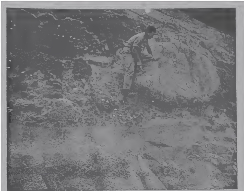
Fig. 34 — O depósito de “tálus” a norte do Country Club: estratificação parcial, blocos e decomposição esferoidal.
